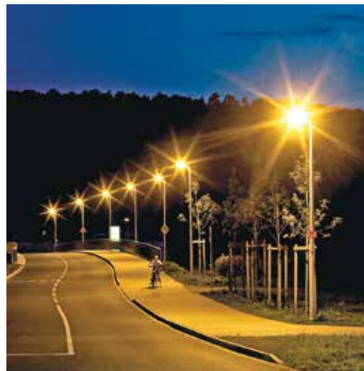
Für Straßenbeleuchtung lief 2012 die Zulassung für ineffiziente Natriumdampflampen aus
