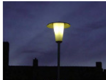
vorher: 1xHME 80W mit KVG (Systemleistung = 82Watt)
