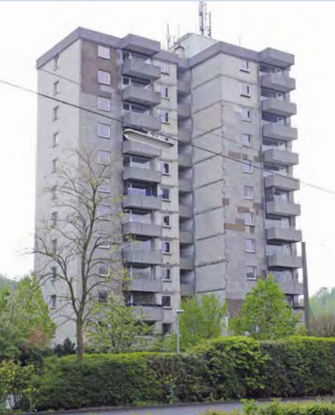
Teilweise geräumtes Wohnhaus
