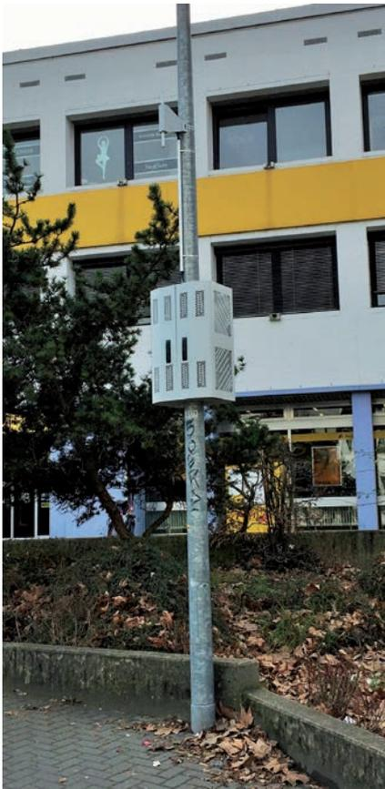
Abbildung 8: Small Cell-Installation mit Umschlussgehäuse an einer Laterne
