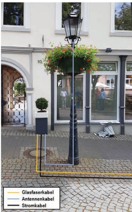
Abbildung 10: Small Cell Anbindung (schematisch)
