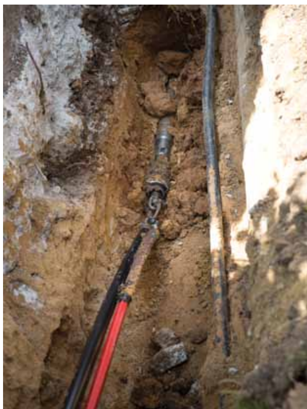
Abbildung 8: Spülbohrverfahren – Bohrkopf an der Einführungsstelle Quelle: atene KOM GmbH, Florian Schuh
