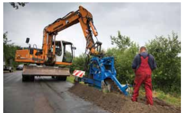
Abbildungen 1 und 2: Offene Grabenbauweise Quelle: atene KOM GmbH, Florian Schuh
