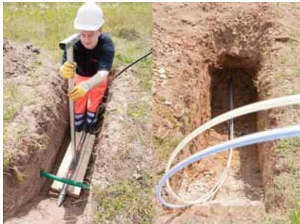
Abbildungen 11 und 12: Erdraketentechnik zur Herstellung eines Hausanschlusses, Quelle: REHAU AG+Co
