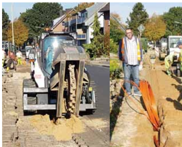
Abbildungen 3 bis 5: Baustellenbereich mindertiefe Grabenfräse Quellen: Deutsche Glasfaser Holding GmbH (3); BMVI (4 und 5)
