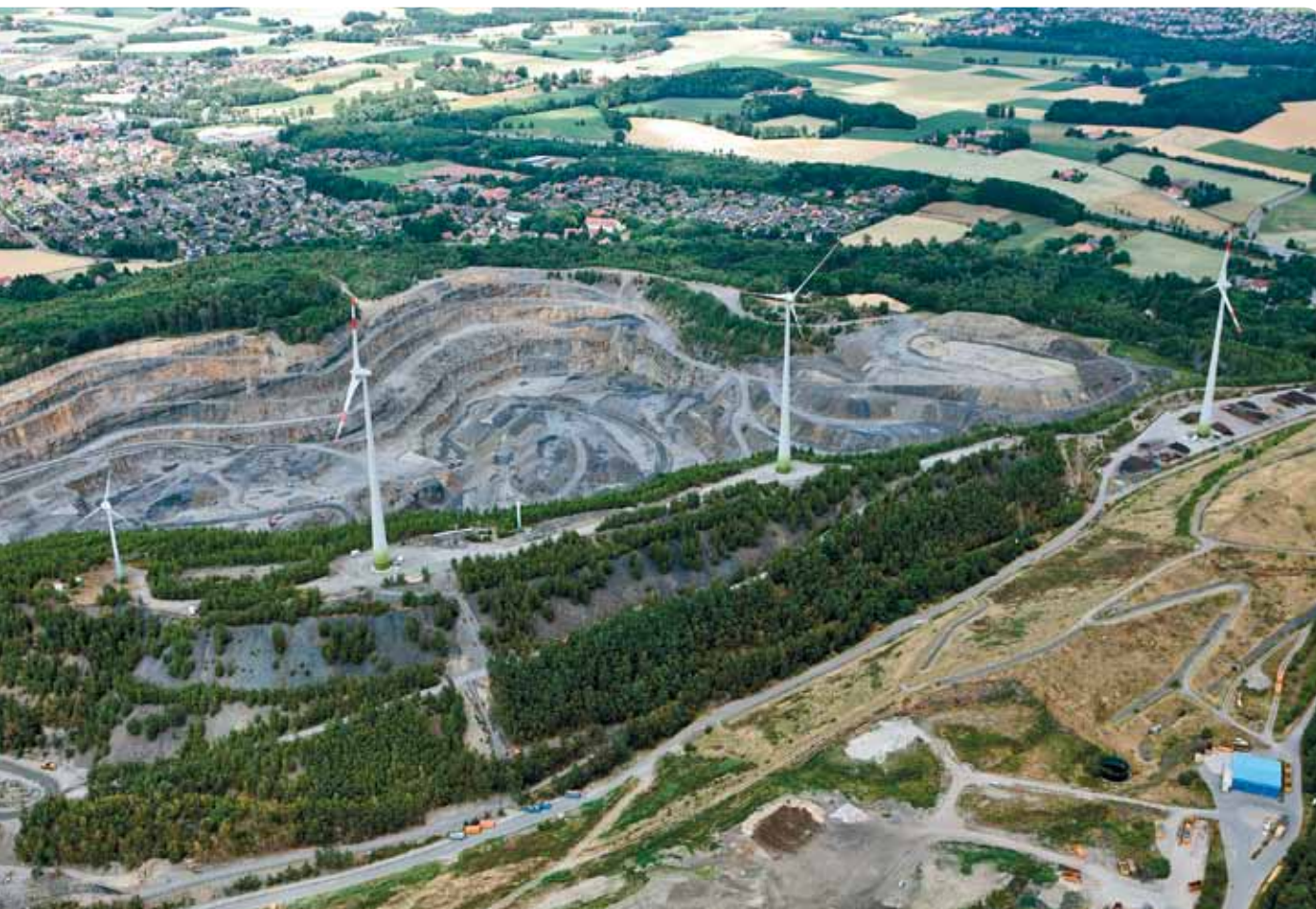
Abbildung 19: Die drei neuen 2 MW-Anlagen auf dem 189 Meter hohen Piesberg mit einer Altanlage (500 kW) und der Ortsteil Lechtingen der Gemeinde Wallenhorst
