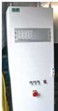
Schaltschrank für die Jalousien- steuerung
