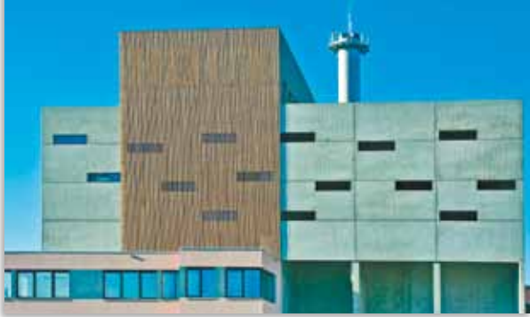
Das Ludwigsburger Biomasseheizkraftwerk
