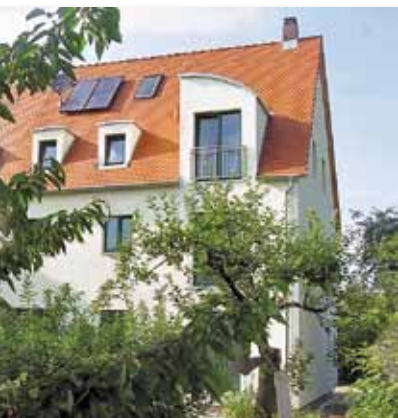
Privatgebäude vor und nach der Sanierung
