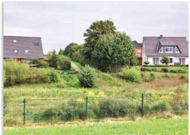
Ein ausgewachsener Knick, der nun auf den Stock gesetzt werden könnte. Im Vordergrund und dahinter das naturnahe Regenrückhaltebecken – aus diesem Baugebiet führt keine Regenwasserleitung heraus.
