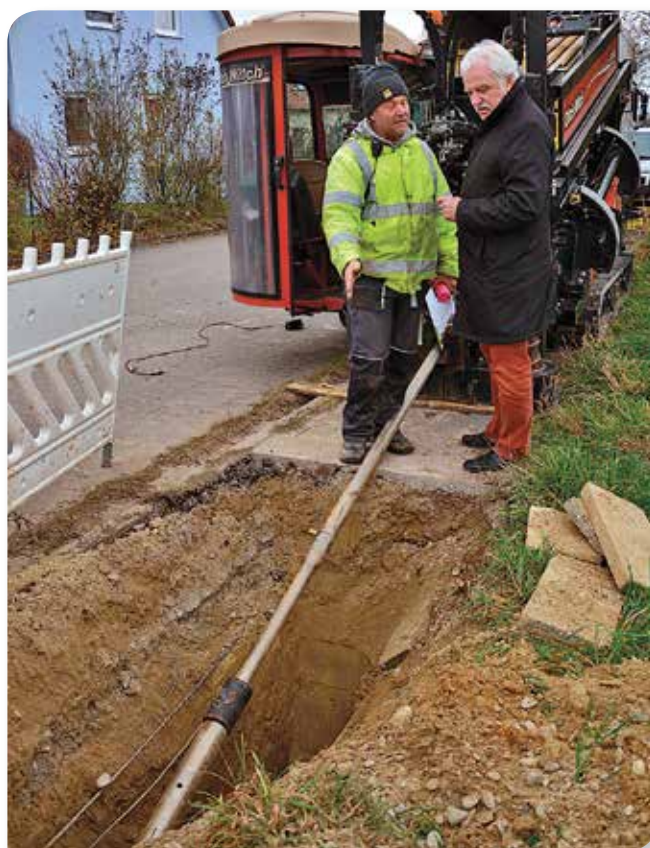
Leitungsverlegung im Spülbohrverfahren
