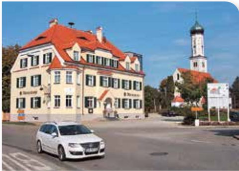
Brauereigaststätte im Gemeindebesitz, saniert, 28 Betten, Städtebauförderung
