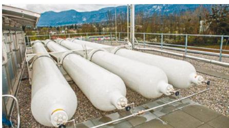
Liegender Druckbehälter
