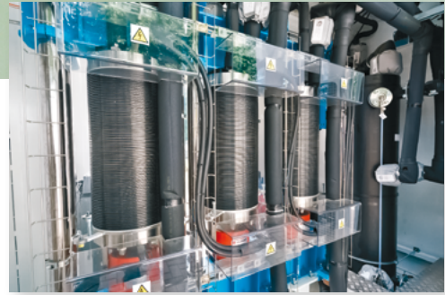
Stacks der PEM- Elektro- lyse
