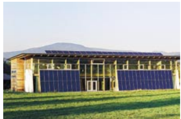
Foto: Sonnenhaus-Institut e. V.
