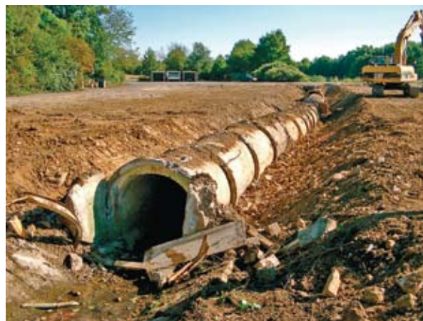
Ein Teilabschnitt des Gleibaches – der vollständig verrohrte Bach bei Beginn der Renaturierungsarbeiten
