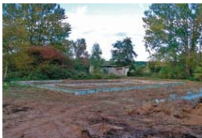
Abriss der Schwimmbecken und alten Gebäude zu Beginn der Renaturierung
