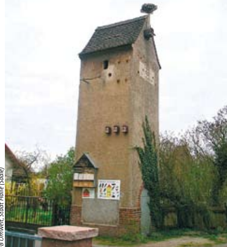
Der Trafoturm Reideburg – eine extra entworfene Informationstafel erläutert dem interessierten Betrachter die Hintergründe der Artenschutztürme
