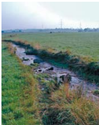
Naturnaher Lauf des Gleibachs nach der Renaturierung – Stör-elemente aus Wurzelstöcken und Steinblöcken fördern die Eigendynamik des Fließgewässers
