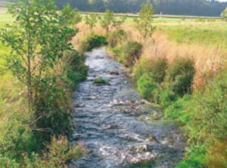
Die neu geschaffene Umgehung an der Lindenmühle führt die Hälfte des Wassers der Schwarzach
