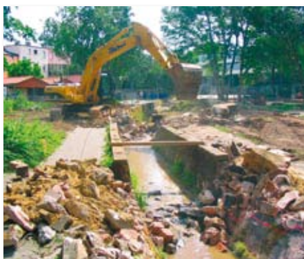
Abriss der Sohl- und Uferverbauung
