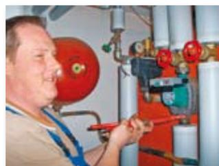
Einbau einer drehzahlgeregelten Heizungspumpe
