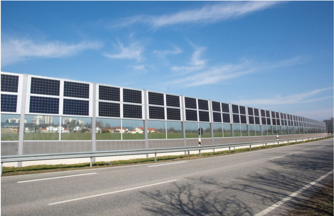
PV-Lärmschutzwand Foto: © Medienzentrum Altötting
