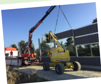
Montage der Photovoltaikmodule Foto: © Fa. MaxSolar GmbH
