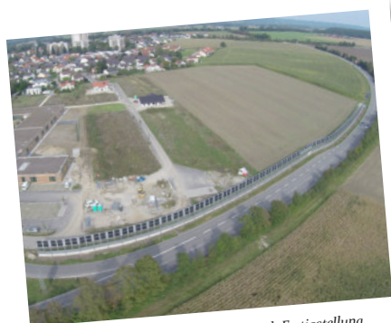
Luftaufnahme der Lärmschutzwand nach Fertigstellung Foto: © EGIS eG
