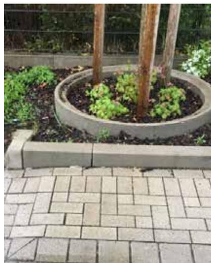
Abb. 7: Abkehr von der klassischen Straßentwässerung durch Nutzung von Baumscheiben zur dezentralen Versickerung von Straßenwasser; Quelle: TBS
