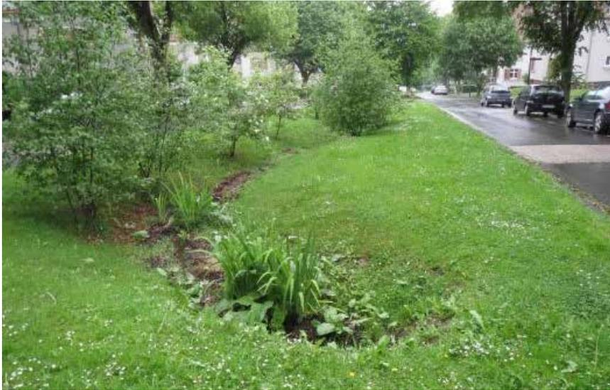
Abb.4: Anstatt Niederschlagswasser von sauberen Dachflächen über die Mischwasserkanalisation aus der Stadt zur Kläranlage zu leiten, wird in verschiedenen Stadtquartieren das Wasser in Mulden gesammelt und langsam dem natürlichen Wasserhaushalt zur Verfügung gestellt; Quelle: TBS.
