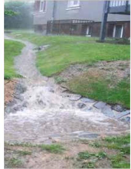
Abb.5: Die Entwässerungsmulden nehmen neben dem Dachwasser auch das bei Starkregen oberflächlich wild abfließende Regenwasser auf und leiten es schadlos weiter; Quelle: TBS.
