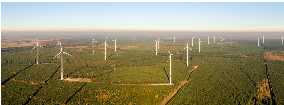
Abbildung 18: Windpark Chransdorf West im Landkreis Oberspreewald-Lausitz (Brandenburg)
