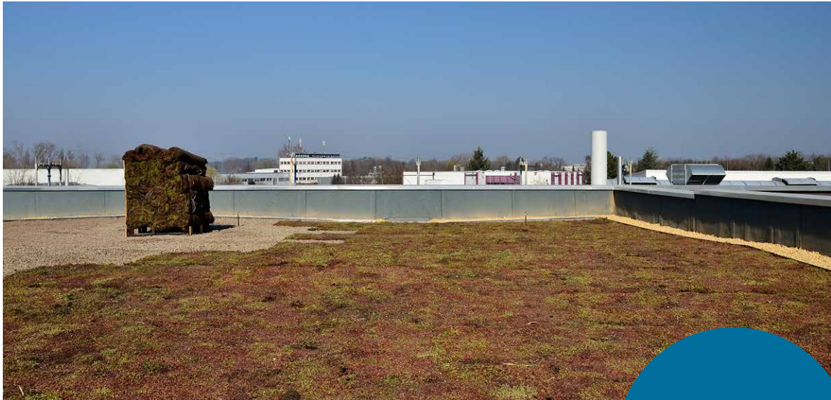
Sedumplatten werden auf dem Depot des LVR-LandesMuseums in Meckenheim aufgebracht
