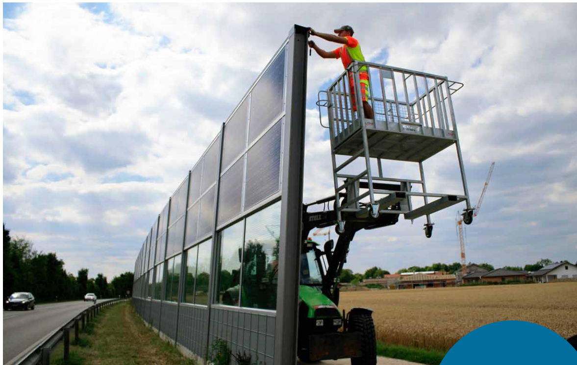
Multifunktionale, modulare Bauweise
