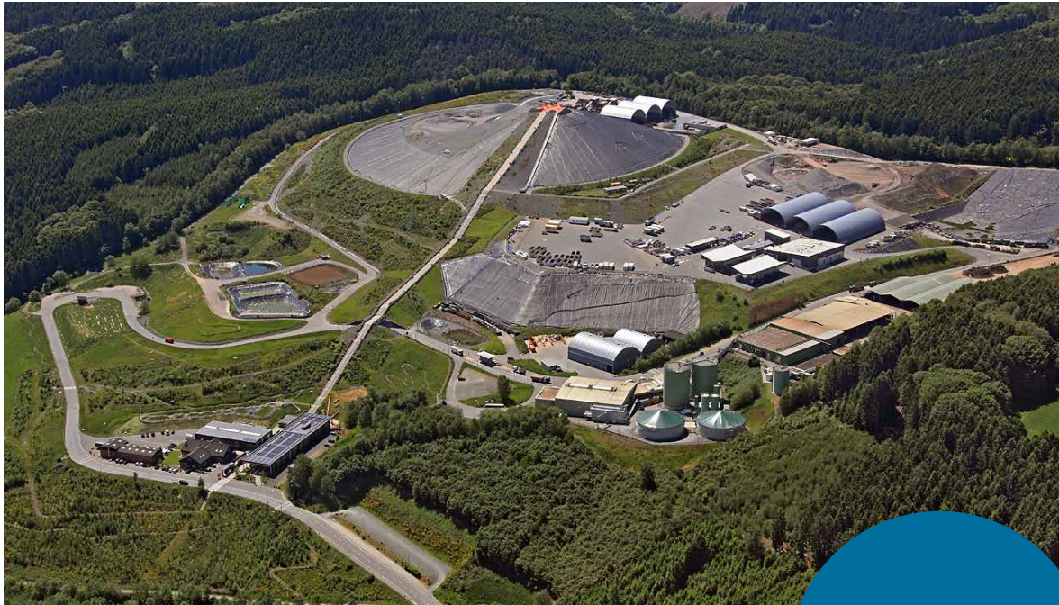
Ehemalige Deponie mit neuem Zweck
