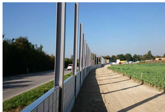
Installation der unteren Lärmschutzzone
