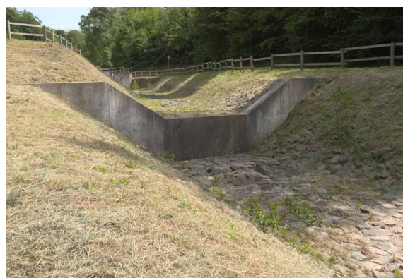
Schwellenabsturzbauwerk mit Tosbecken
