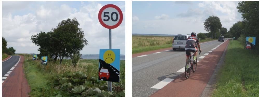
Bild 2-5: Schutzstreifen außerorts in Dänemark mit großformatigen Hinweistafeln zum richtigen Fahrverhalten (Fotos: T. Schönefeld)
