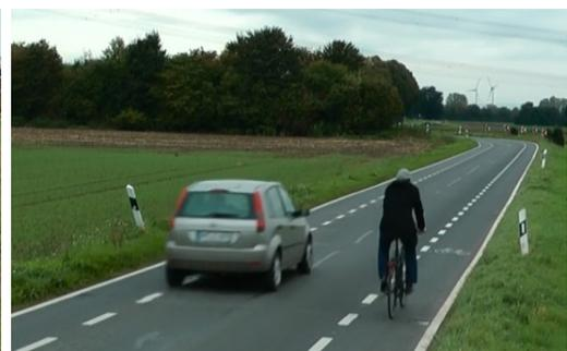
Bild 7-9: Flächenbelegung beim Überholen, Pkw fährt „innerhalb des Schutzstreifens der Gegenrichtung“
