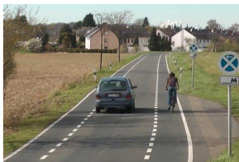
Bild 7-8: Flächenbelegung beim Überholen Pkw fährt in „Kernfahrbahn“
