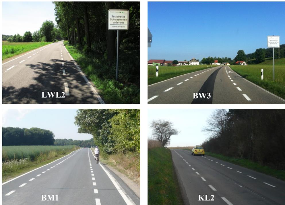
Bild 6-6: Beispiele für unterschiedliche Erkennbarkeit der entfernten mittleren Leitlinie (Foto: Urbanus - oben links; PGV-Alrutz - oben rechts; AB Stadtverkehr - unten links und rechts)
