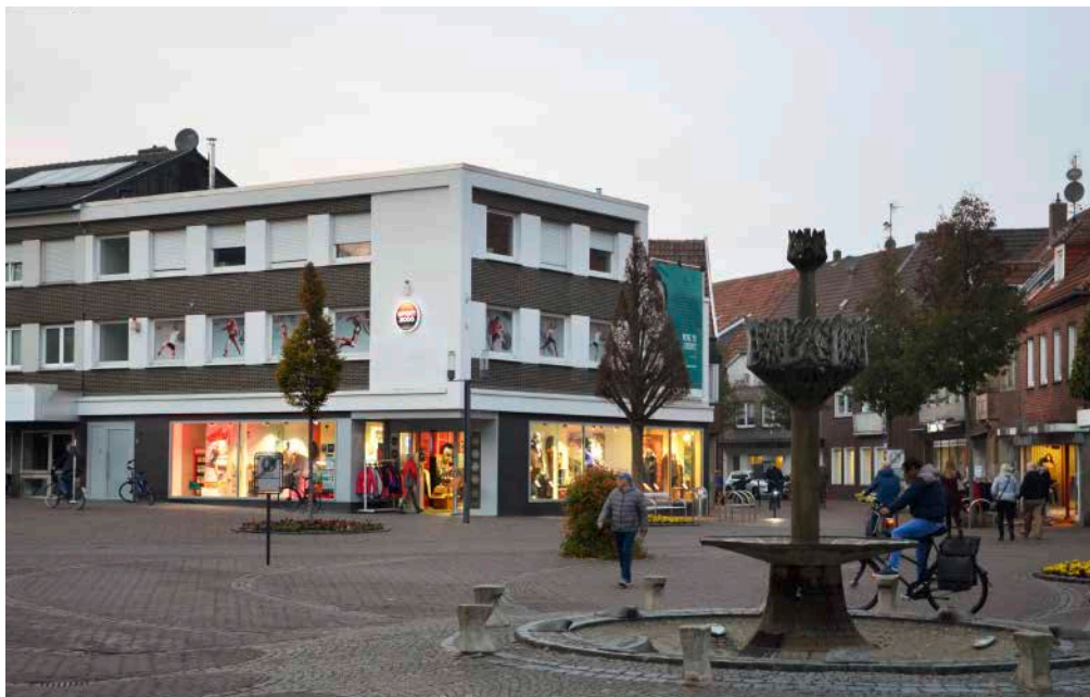
Bild 2: Aufwertung des Stadtbildes: Mit kommunalem Programm geförderte Fassadensanierung am Marktplatz in Vreden © TU Kaiserslautern
