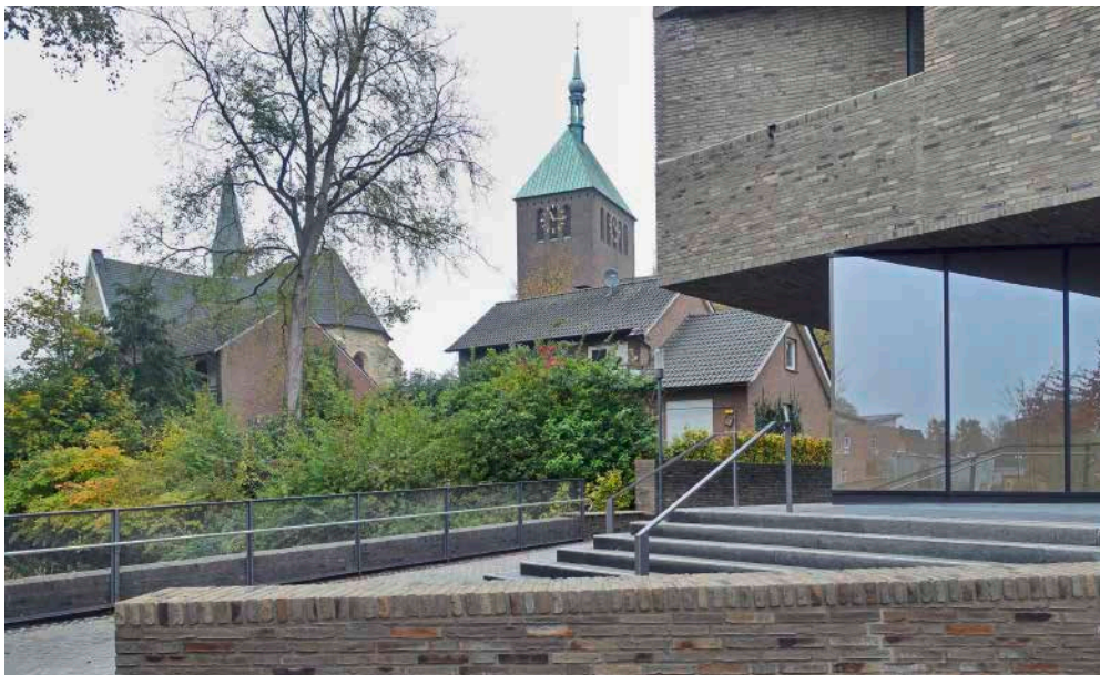
Bild 1: Gelungene Verknüpfung von neuer Baukultur mit den historischen Freiräumen: Das Kulturquartier „kult“ in Vreden © TU Kaiserslautern
